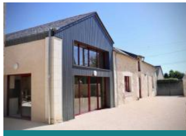
Au Logis du Prévôt
