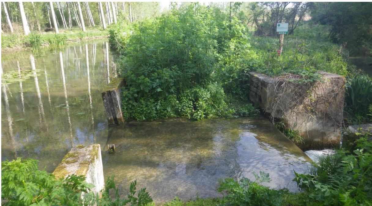
Figure 22 : Seuil en amont du site, partageant les eaux entre le Négron et le fossé central (PNR LAT)
