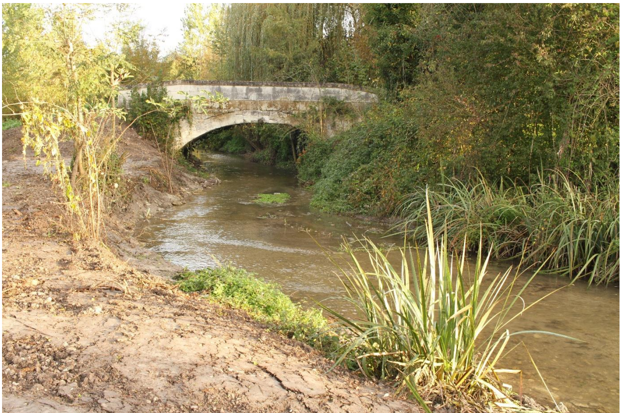
Figure 18 : Pont de la réserve
