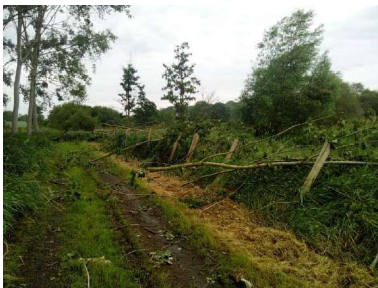
Figure 23: Photographie de la clôture après les intempéries survenues en juin (photo CC CVL)
