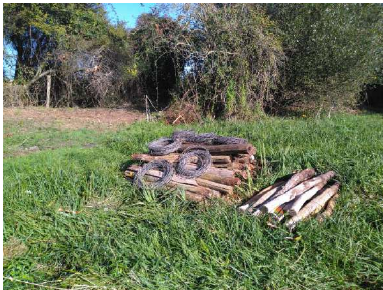
Figure 20 : Démontage d'une partie des clôtures (photo CC-CVL).
